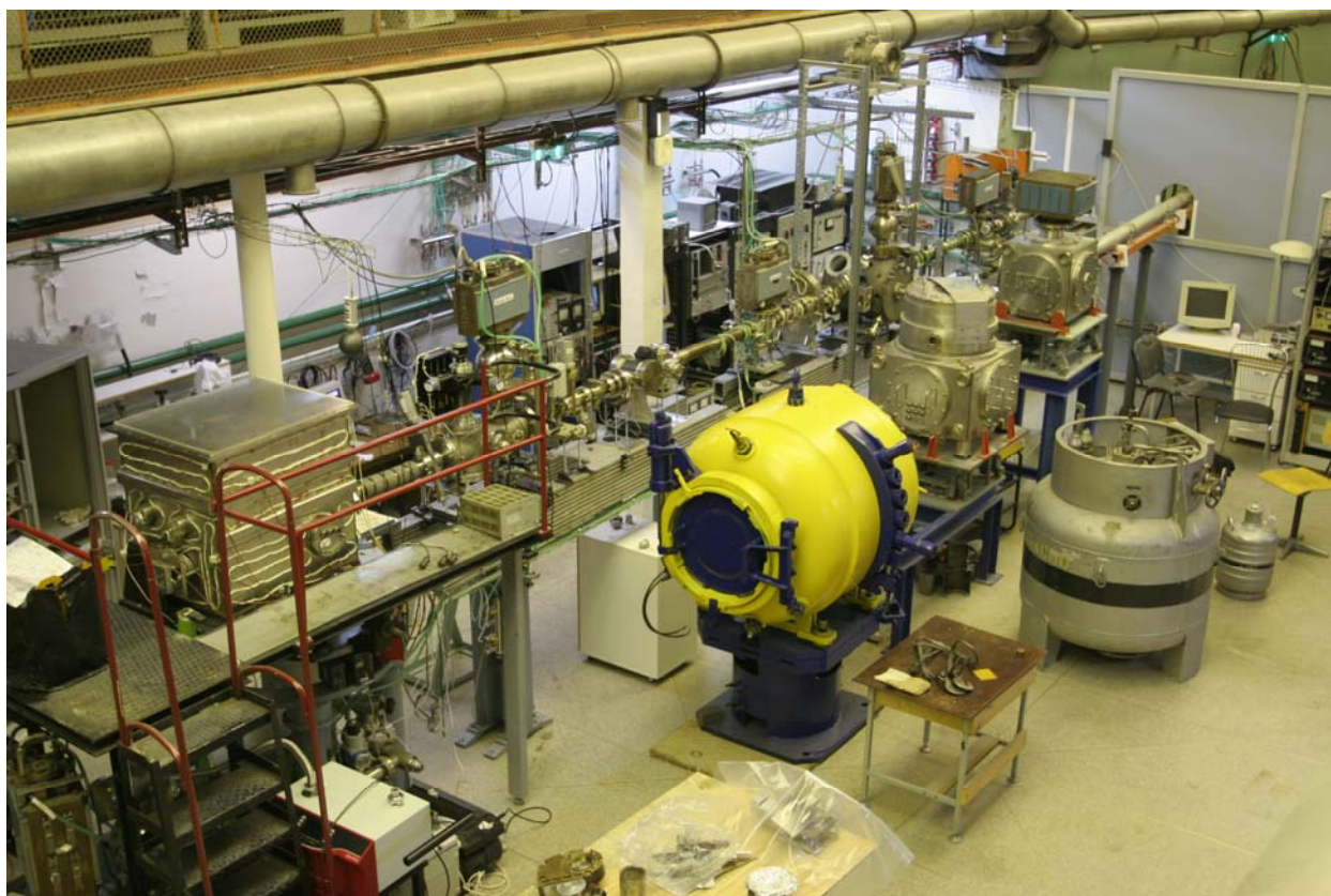
Рис. 25. Бункер СИ на ВЭПП-4. На переднем плане создаваемая станция “Взрыв”. На заднем плане действующая метрологическая станция “Космос”.
