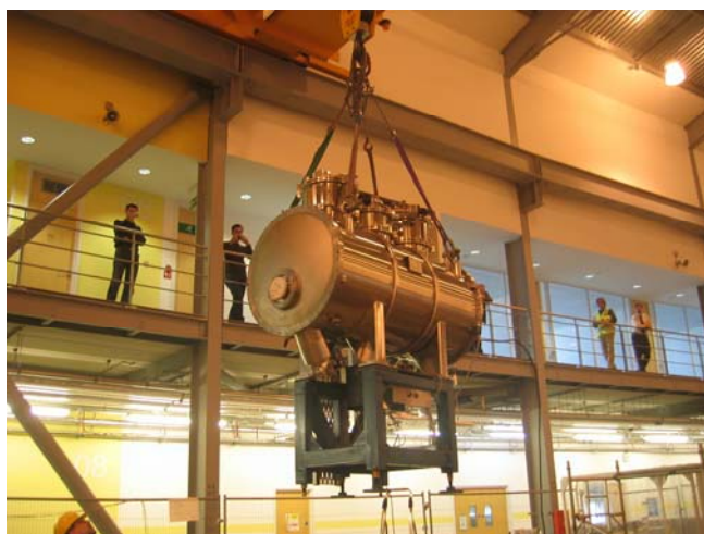
Рис. 57. Монтаж 49-полюсного вигглера с полем 4.3 Тл на накопитель DLS (Англия).
