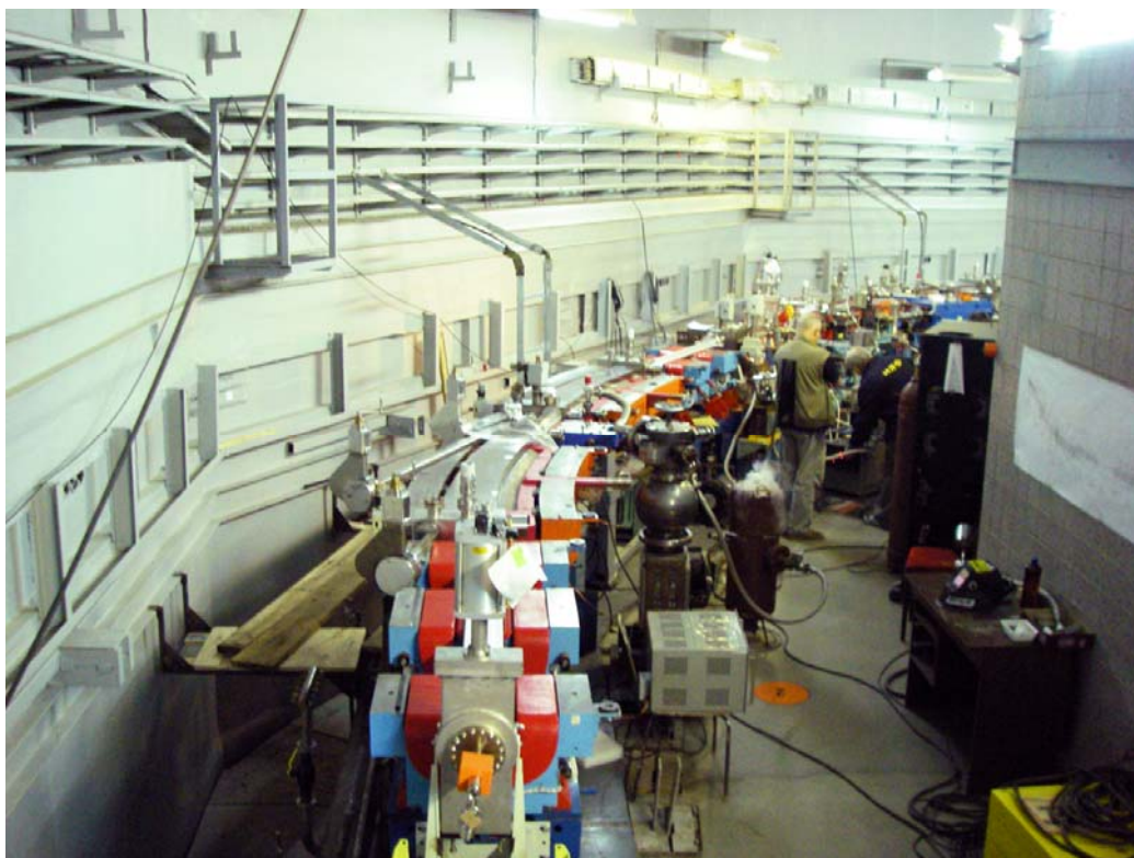
Рис. 53. Рабочий момент монтажа вакуумной системы большого кольца источника СИ «Зеленоград».
